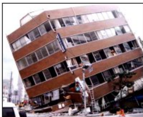
事務所ビル1, 2階の崩壊
