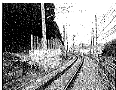
【落石防止擁壁の一例】
