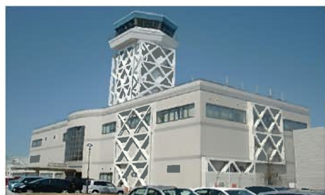
庁舎・管制塔等の倒壊防止
