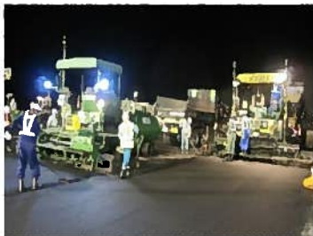
（誘導路舗装の改良）
