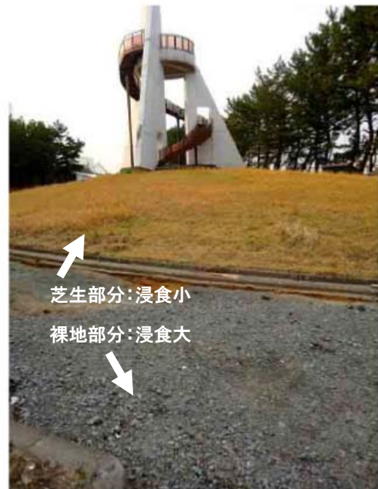
園路の裸地部分は激しく浸食されているが、 展望台下の芝地の浸食は軽微である。 （福島県相馬市相馬港新地緑地）
