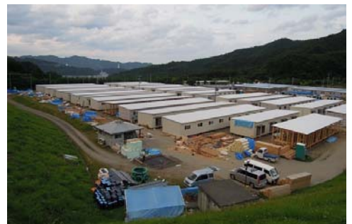
仮設住宅用地 (釜石平田総合公園)
