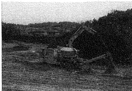
図5.1 伐採木の破砕状況<sup>2)</sup>
