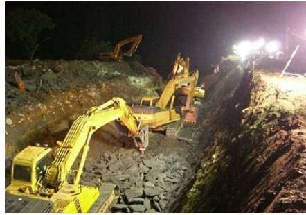
仮排水路掘削イメージ(他事例)
