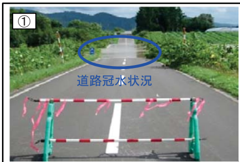
町道誉大富1号幹線冠水及び通行止め状況
