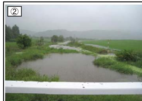
誉平幹線排水路氾濫状況
