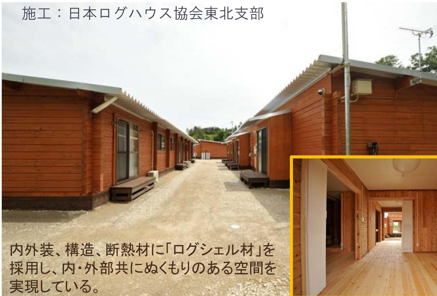
内外装、構造、断熱材に「ログシェル材」を採用し、内・外部共にぬくもりのある空間を実現している。
