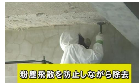
例 (アスベストの除去作業)
