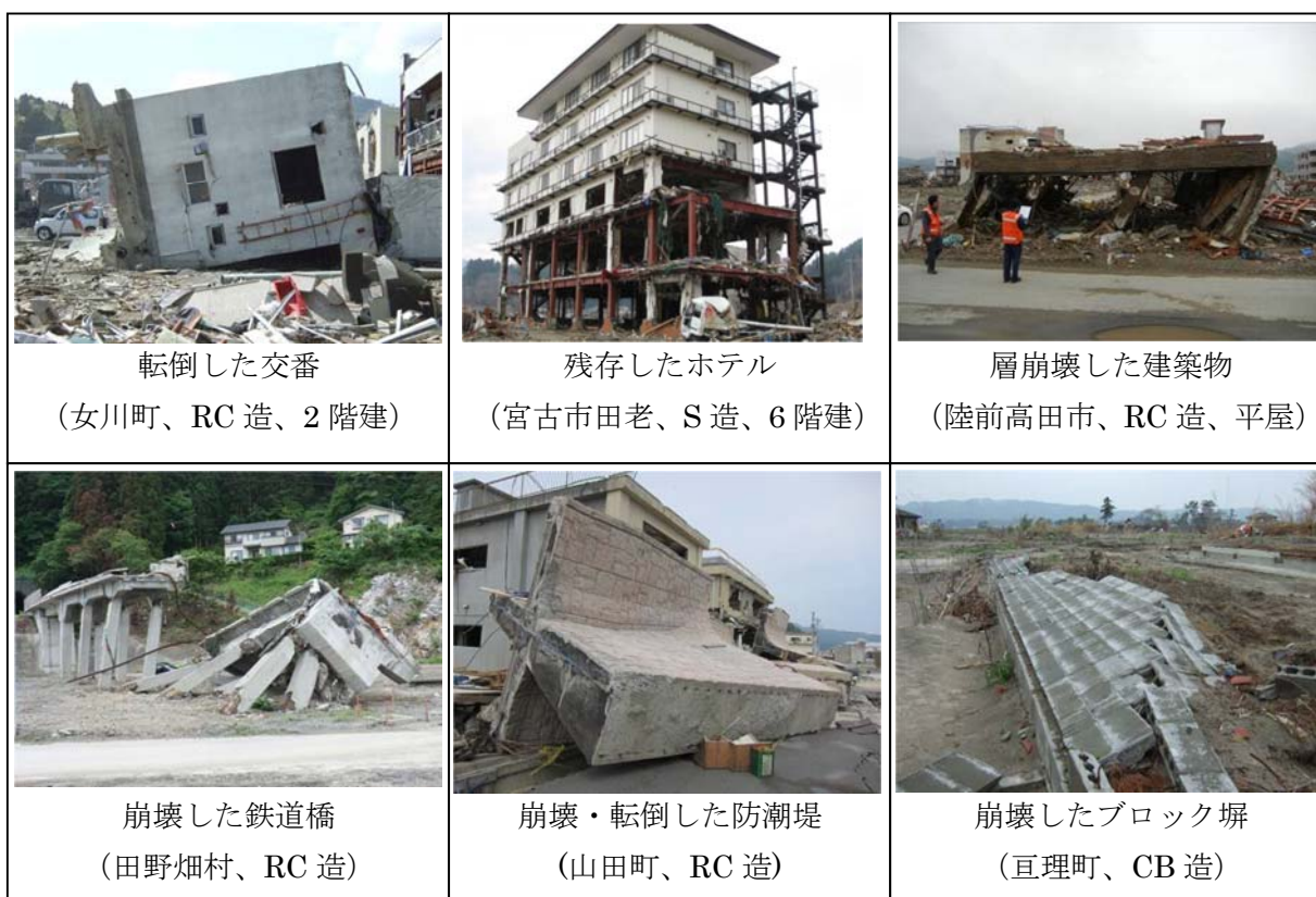
図 3.2 調査地域と被害状況写真例
