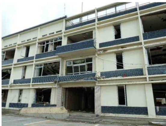
写真 2.5 残存した直接基礎の公共建築物 (RT-02(非転倒建物))
