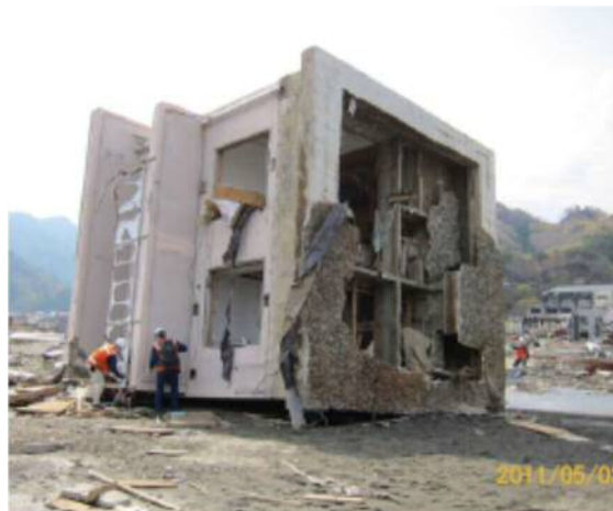
写真 2.4 水深係数 a が 1 より大きいにも関わらず転倒した建築物 (OT-04)
