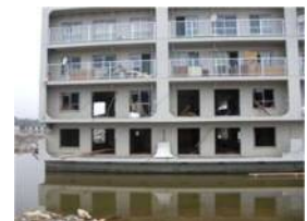
図 5.6 波力低減を意図した構造計画案 (外壁 ALC とした場合)
