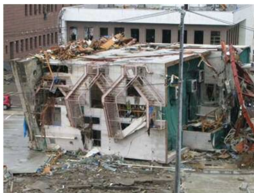
写真 1.1 3階建て鉄骨造の転倒
