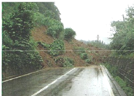
▲並行する国道158号 【土砂崩落による通行止め】
