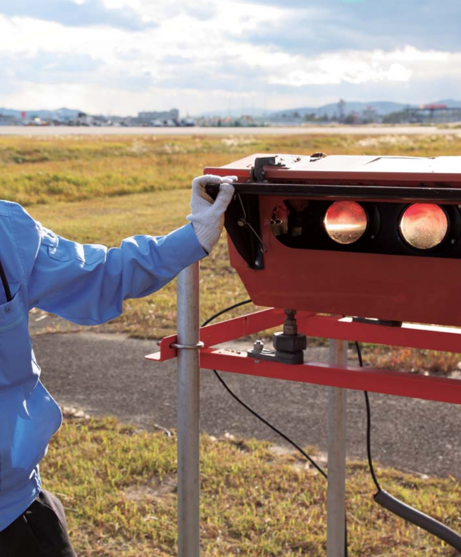
進入角指示灯 (PAPI) の角度をチェックする入江。台風時などはフードで中のライトを保護する。
