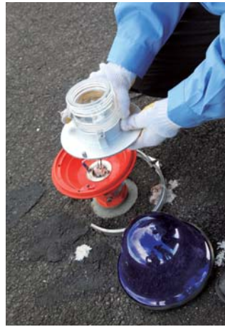
滑走路の灯火は分解して電球のチェックも。電球にはハロゲン灯が採用されている。
