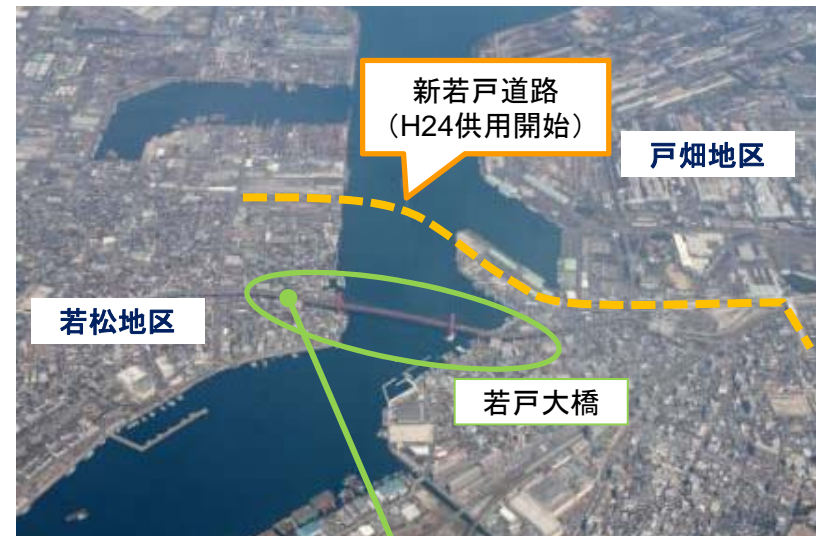
若戸大橋混雑状況
