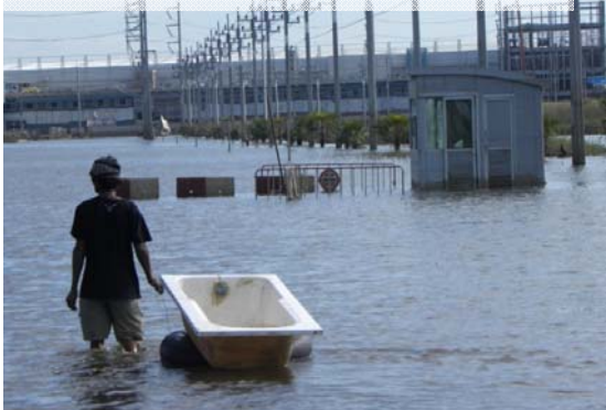
【排水前 (11/23) ロジャナ工業団地】
