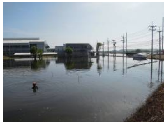
排水前の状況(11月19日)
