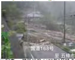
写真 被災状況（H23年9月時点）
