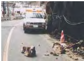
図1 落石発生状況
