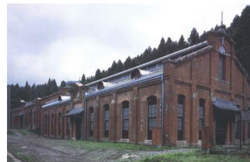
碓氷峠鉄道施設旧丸山変電所(重要文化財)
