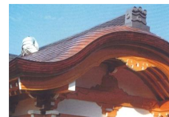
専念寺唐破風銅板工事
