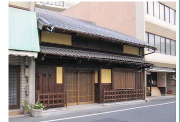
修景された家屋（宇治橋通り）
