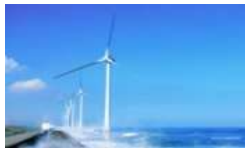
【風力発電設備】
