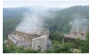
【地熱発電設備】
