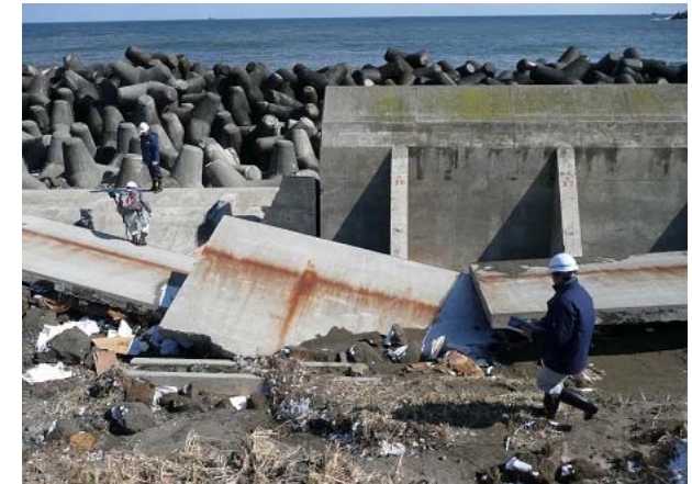
八戸港の被災調査状況
