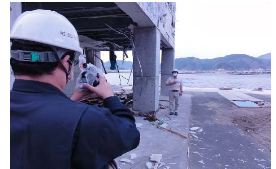
測距機における遡上高さ調査状況
