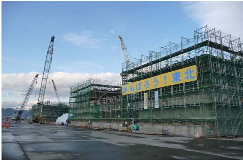
宮古港 ケーソンヤード
