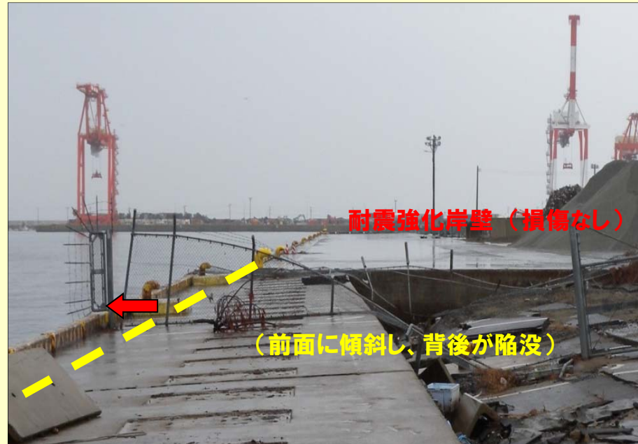
仙台塩釜港の耐震強化岸壁
