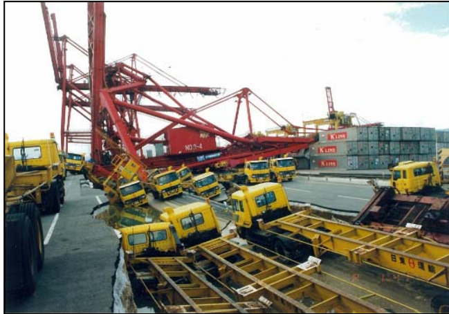
コンテナターミナルの被災状況
