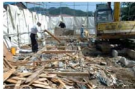
土台を残し上部構造部を解体後の状況
