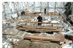
CCA 処理木材の手作業による運搬状況
