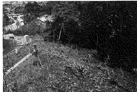
図 5. 2 のり面肩部のマルチング状況 2)
