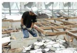
土台の取外し状況
