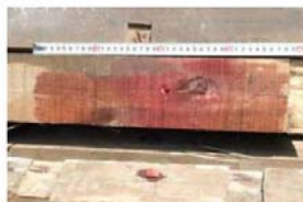
CCA 処理木材の試薬による確認状況
