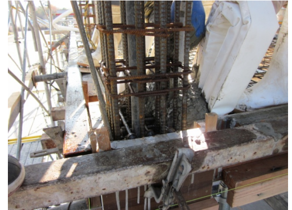
コンクリート打設
