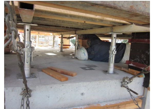
コンクリート打設時下階
