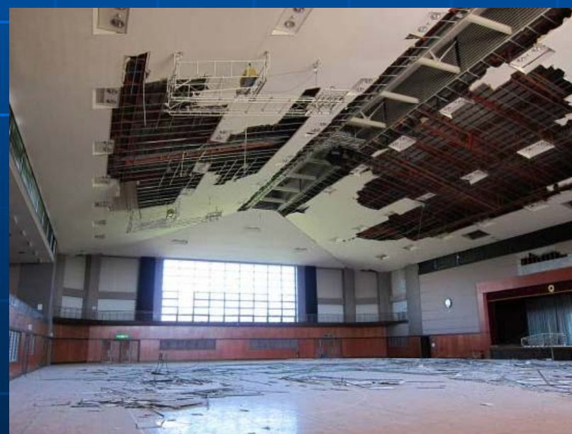
山形架構の屋根面に平行な天井
