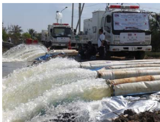
ポンプ排水の活動状況
