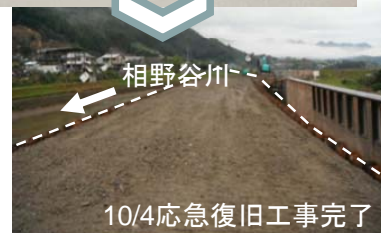
相野谷川（紀宝町） 堤防崩壊 鋼矢板二重締切工法による仮堤防を構築し、被災前の高さを確保済み。
