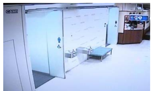
1F トイレ横に設置された水飲み台
