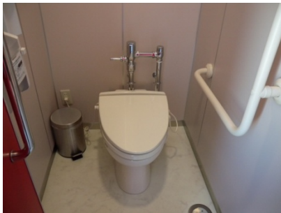
一般トイレの大便器への手すりの設置。扉は折戸。（7F女性トイレ）
