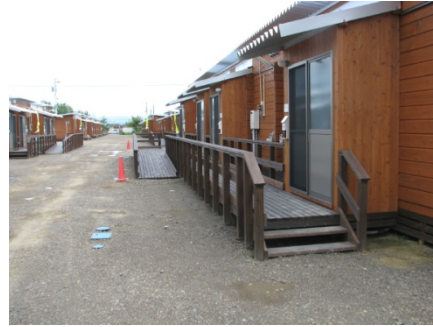
応急仮設住宅の様子
