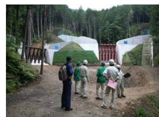
砂防ボランティアとの 砂防設備点検 (愛知県豊川市)
