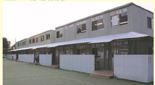
■仮設ハウス(南三陸町仮庁舎)
