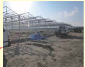
■大型ハウスを整備(名取市)
