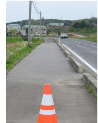
対策箇所(被害なし)
