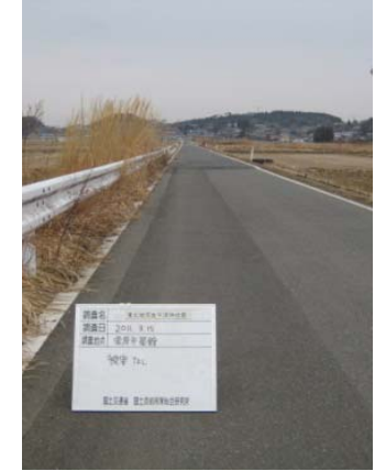
対策箇所(被害なし)
