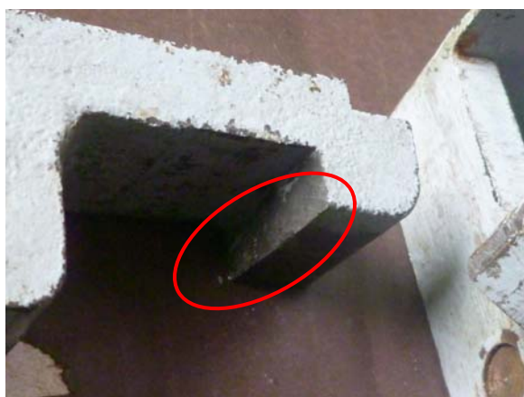
(写真 I-10) ラッチ部分
