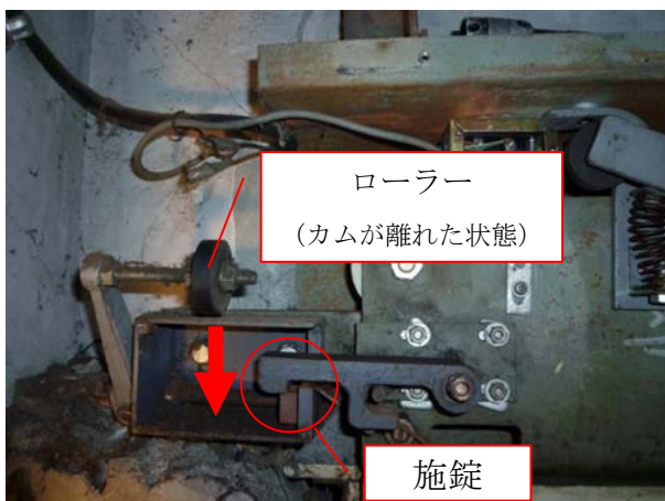
(写真II-3) 乗場扉開閉時の施錠装置の動き
