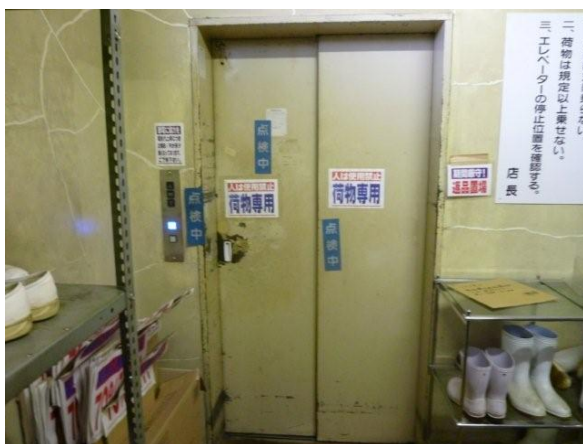
(写真 I-1) 2階エレベーターホール
