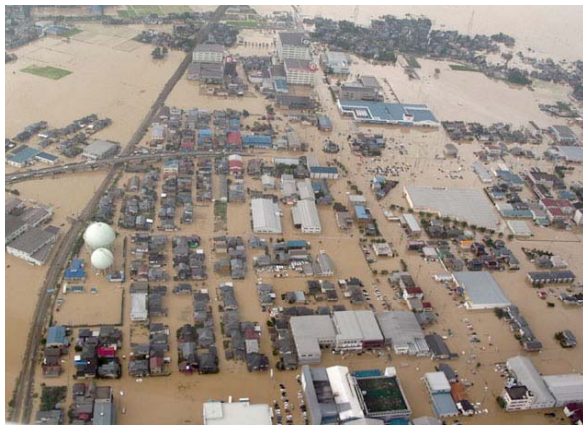
堤防決壊による浸水状況
