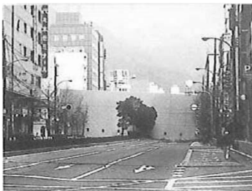
阪神・淡路大震災において建物の倒壊により道路が閉塞された状況
