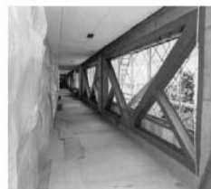
鉄骨ブレースによる壁の補強
