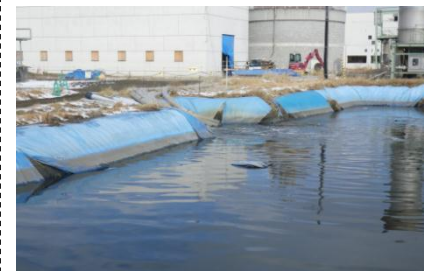
応急復旧の事例(仮設沈殿池・素堀)
