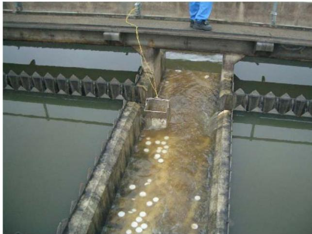
図 3.16 固形塩素による初期段階の消毒の状況（仙台市南蒲生浄化センター）
