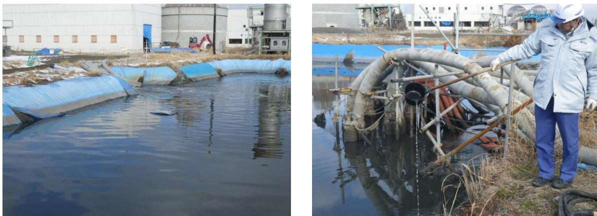
図 3.4 仮設沈殿池の設置事例（宮城県県南浄化センター）
