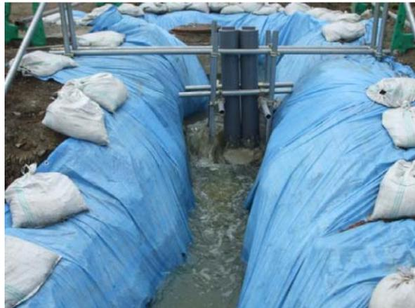
図 2.3 素掘水路で近傍水路へ導水した事例（青森県馬淵川流域）
