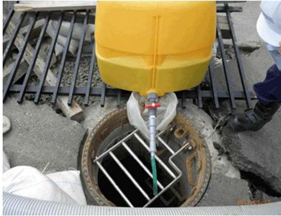
図 2.6 緊急排水のための簡易消毒実施状況（宮城県県南浄化センター）
