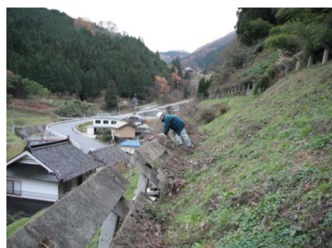
雪崩防止施設点検（岡山県）
