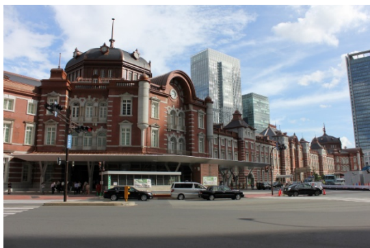
【復原された丸の内駅舎】
