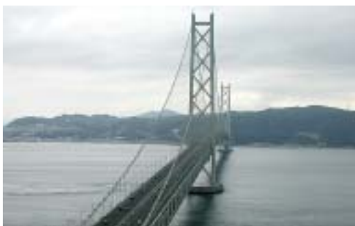
明石海峡大橋
