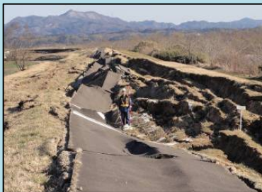
東日本大震災での河川堤防の液状化被害について、復旧方法等の技術的助言を行い、洪水期の安全確保に貢献
