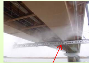
橋梁洗浄機の開発 橋梁洗浄の実施
