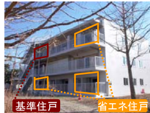
国土技術政策総合研究所・建築研究所内に建つ実証実験棟の外観 省エネ設備を省エネ住戸に導入し基準住戸に設置した基準設備と比較させて実動性能を計測した
