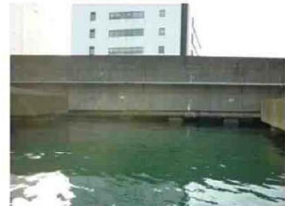
満潮時の栈橋構造 （海面近接部）
