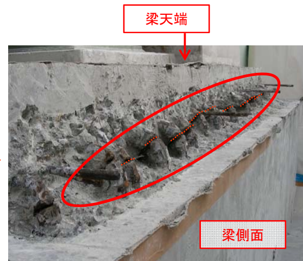
鉄筋の破断
