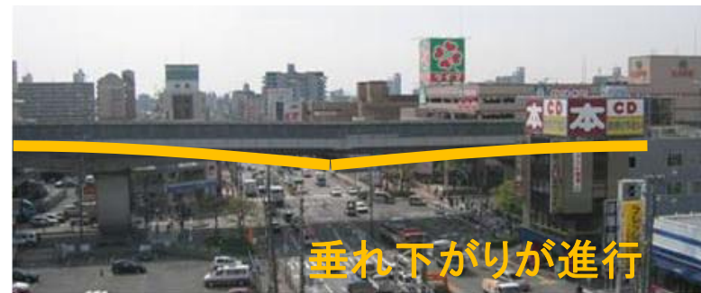
支間中央有ヒンジ部において、路面の垂れ下がりが進行k
