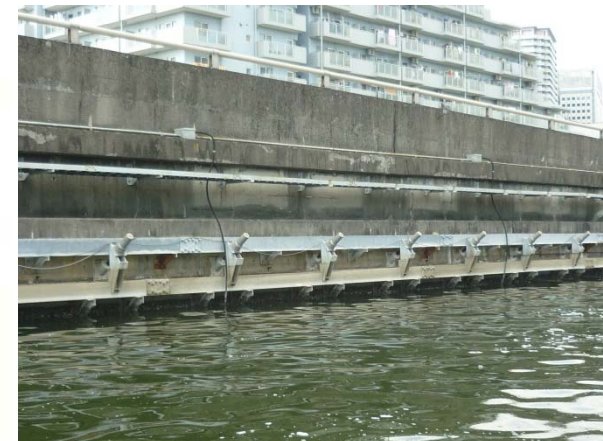
グラウンドアンカーによる補強 （平成20年）
