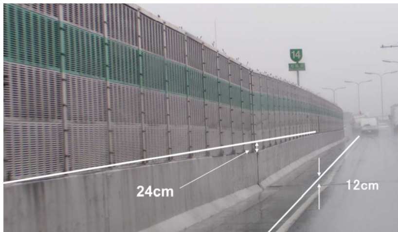
支間中央有ヒンジ部において、路面の垂れ下がりが進行k
