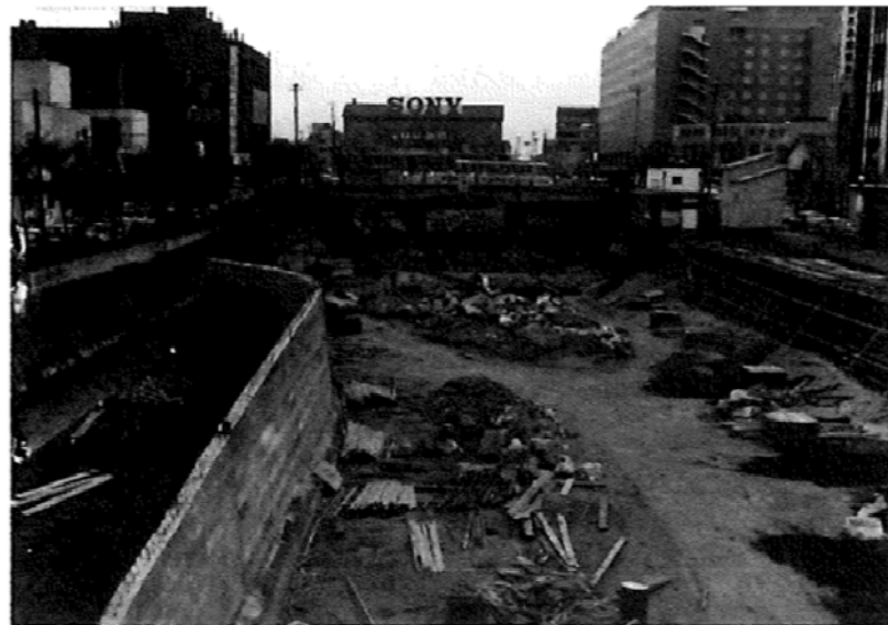
(工事時の状況)
