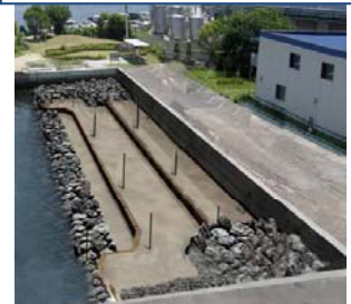
生物共生型護岸の整備
