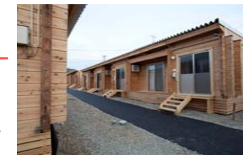
被災者向け住宅 (東日本大震災)
