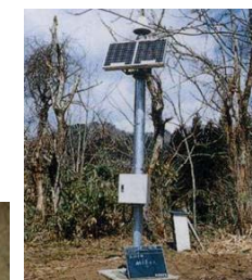
GPSを活用した地すべり監視
