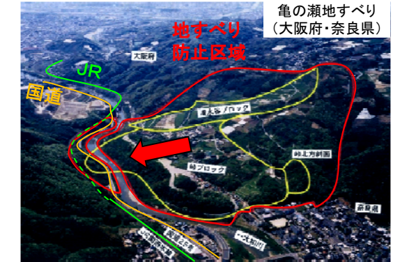
重要交通網を保全する地すべり防止施設の整備
