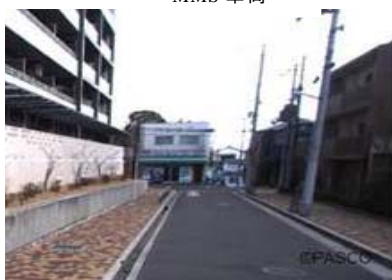
図1 MMSにより撮影された映像
