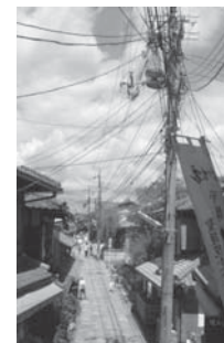
<美観を損ねる電柱・電線>
