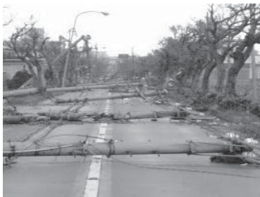
<電柱の倒壊による道路閉塞>
