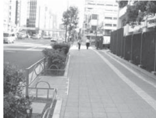
＜幅の広い歩道の整備や視覚障がい者誘導用ブロックの設置＞
