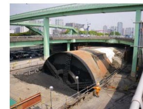
到達状況(高速道路工事)
